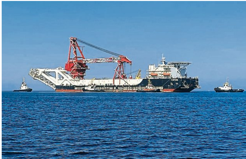
„Fortuna“ heißt das russische Verlegeschiff, das die Rohre der Pipeline in dänischen Gewässern verlegt. 94 Prozent von Nord Stream 2 sind fertiggestellt. FOTO: OLIVER DENZER/REUTERS
